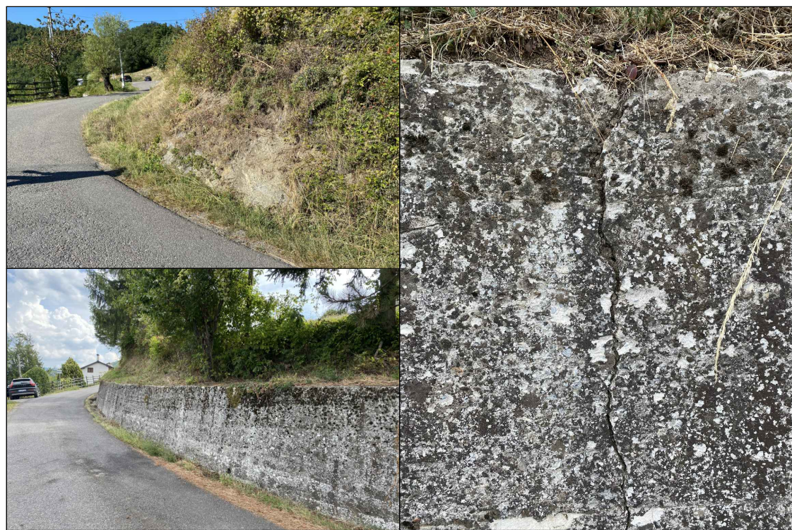
FOTO MURO 1 e 1a
