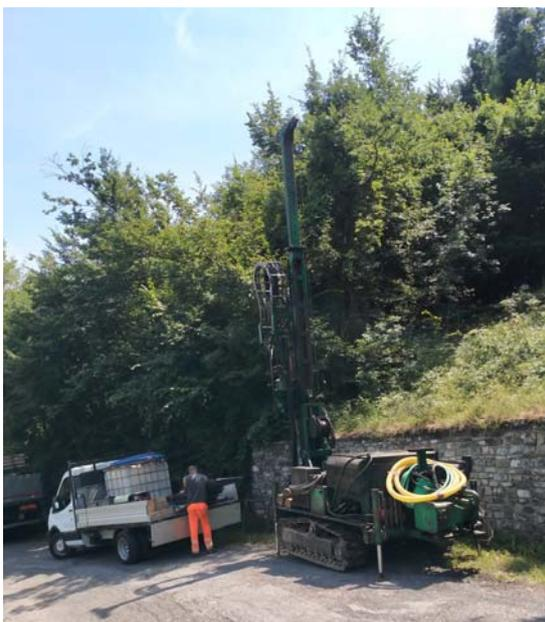
**Foto 1** – Sonda Geomarc GM600 sul punto di perforazione S2
